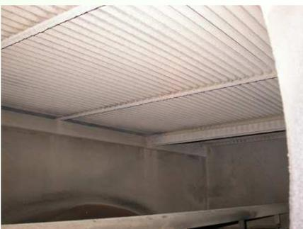
Economiser mit nasser Abreinigung in einer BM-KWK-Anlage
