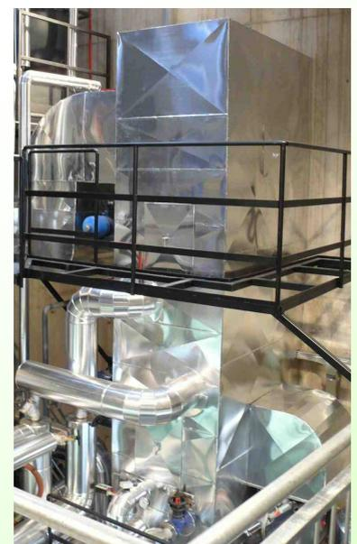
Economiser mit Druckluft-abreinigung in einer BM-KWK-Anlage
