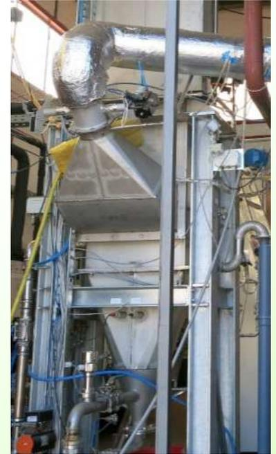
RGK Versuchsanlage mit direkt gekoppelter Wärmepumpe, Projekt ICON
