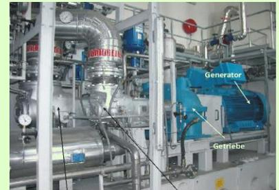
Dampf-Schraubenmotor der KWK-Anlage Hartberg
