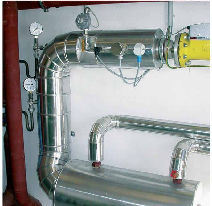
Abb.2. Ansicht Gasmessstrecke Biogasmessung – Messstelle 4
