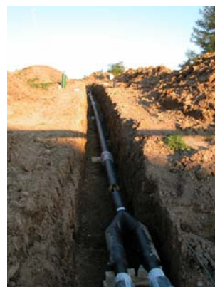
Verlegung von Fernwärmerohren
