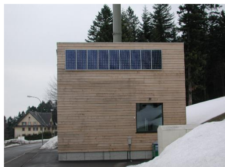
Außenansicht eines Biomasseheizwerkes
