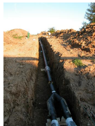
Verlegung von Fernwärmerohren
