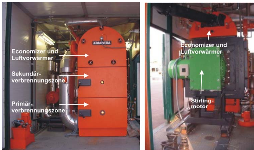
Abbildung 3: Bilder der Pilotanlage auf Basis eines 35 kW el Stirlingmotors
