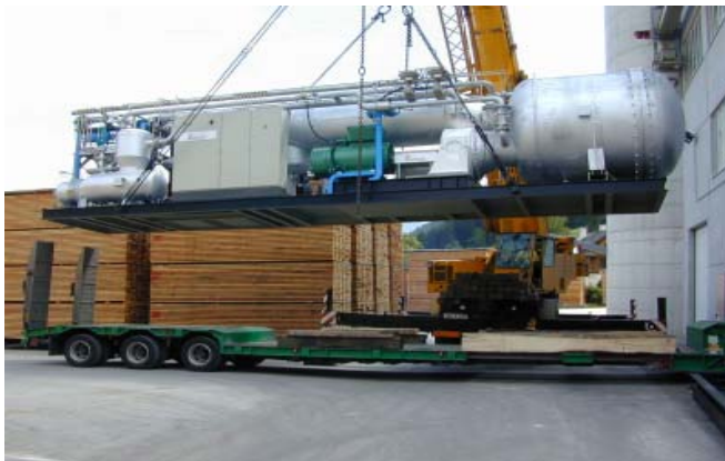
ORC Modul in Containerbauweise (400 kW el ) bei der Einbringung in eine Biomasse-Kraft-Wärme-Kopplungsanlage
