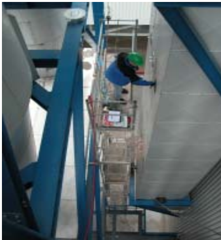
Feldmesseinsatz an einer Biomasse-Kraft-Wärme-Kopplungs-Anlage
