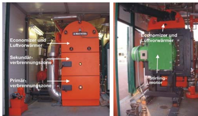
35 kW el Pilotanlage auf Basis Stirlingmotor
